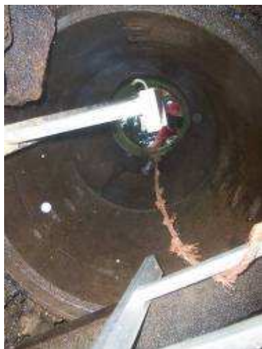
Vue d'en bas du puits
