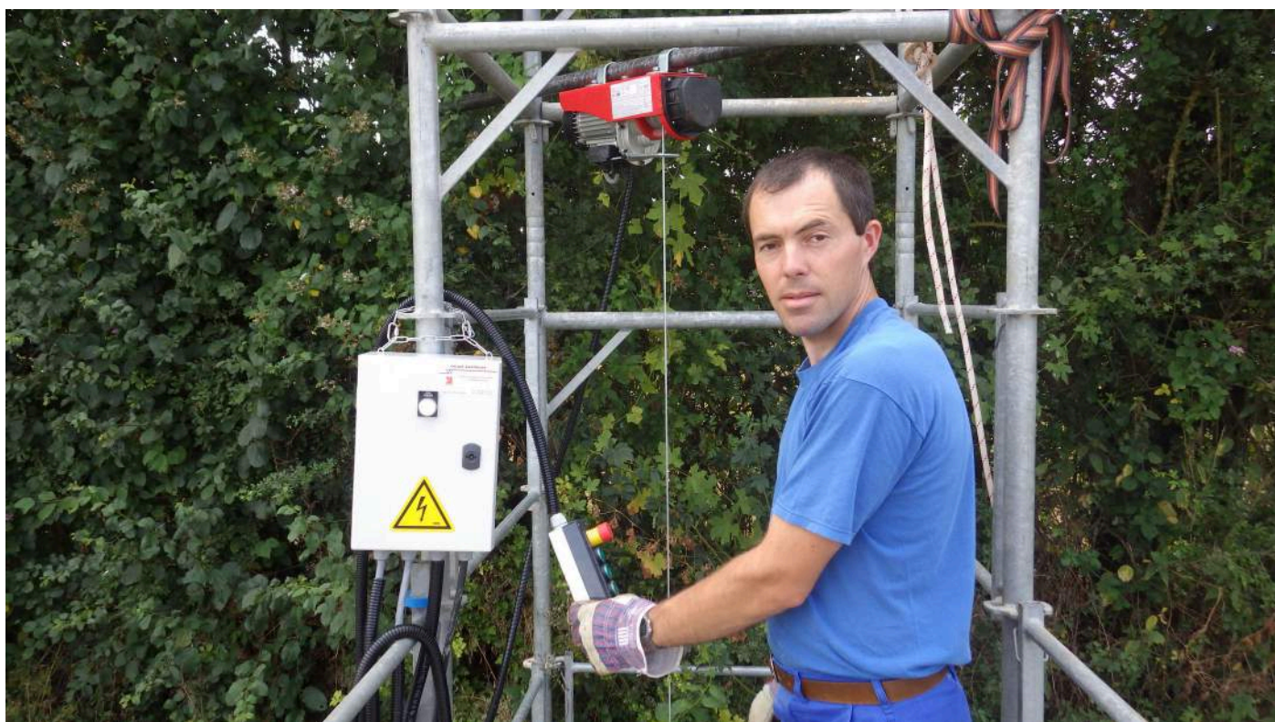
Photo : Sandrine COLLON Treuil en tête de puits
