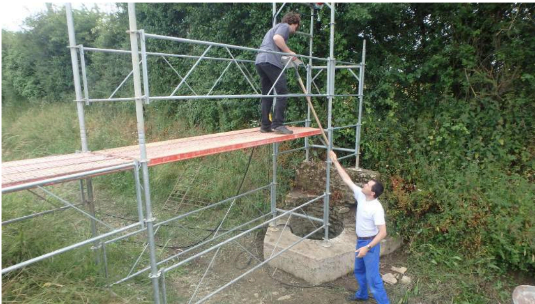
Fin de montage de l'échafaudage et mise en place du treuil
