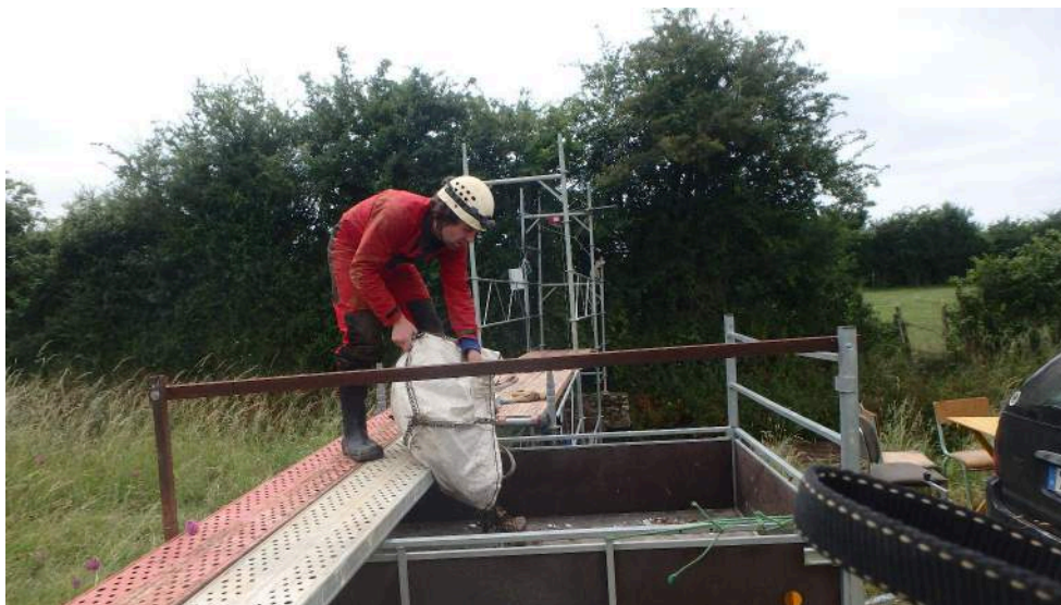
Chargement des déblais dans la remorque
